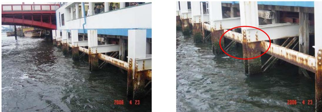
图 1.4 钢桩浪花飞溅区腐蚀和涂层破坏
