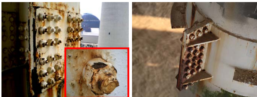
图 1.1 螺栓连接处腐蚀实例
