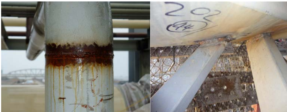
图 1.4 焊接部位腐蚀实例
