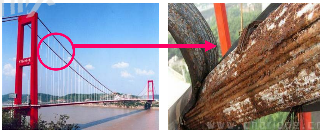
图 1.5 桥梁钢索腐蚀实例
