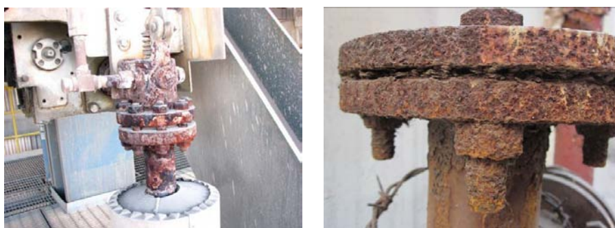
图 1.3 法兰连接处腐蚀实例
