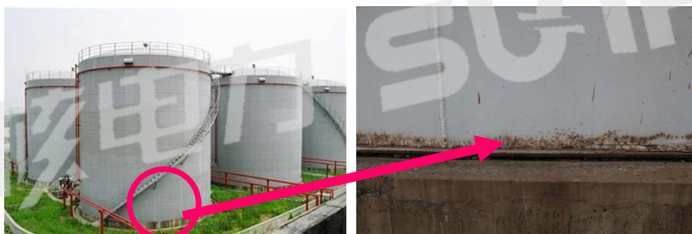
图 1.2 储罐边缘板腐蚀实例
